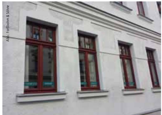
Abb. 11: Im Erdgeschoss wurde ein Leierspritzputz mit Glimmer angetragen.
