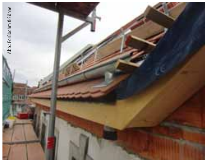
Abb. 5: Dachstuhl und das Dach wurden nach alten Plänen, die im Archiv noch vorhanden waren, neu aufgebaut.
