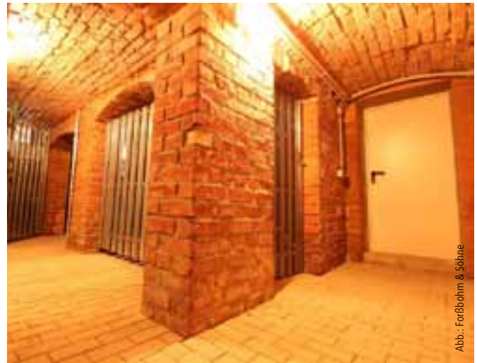
Abb. 9: Die erdberührten Wände waren nicht stark durchfeuchtet und sind mittlerweile noch weiter abgetrocknet.
