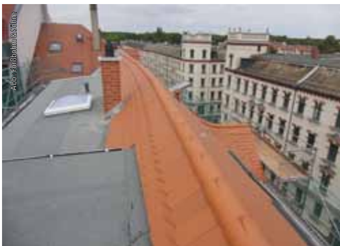
Abb. 6: Das Gebäude besteht aus zwei Hälften, die in der Mitte in einem leicht stumpfen Winkel aufeinanderstoßen. Der Dachstuhl musste daher in einem Segmentbogenabschnitt zusammengeführt werden.
