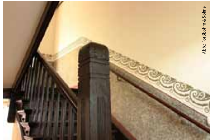
Abb. 14: Von der Treppe mussten nur wenige schwammbefallene Teile ausgetauscht werden. Für die Schablonenmalerei wurden die alten Muster und Farbgebungen aus alten Farbschichten ermittelt.
