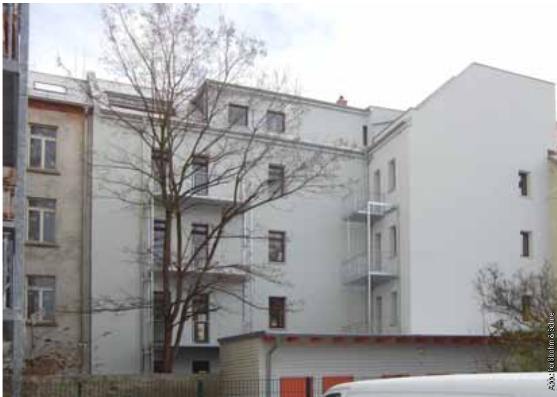
Abb. 12: Auf der Hofseite wurde ein Wärmedämm-Verbundsystem aus EPS-Dämmplatten mit einer Gesamtdicke von 14 bis 16 Zentimetern aufgebracht.
