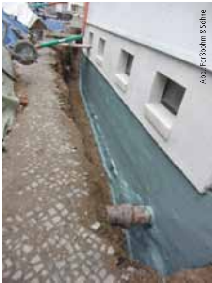
Abb. 8: Horizontal wurde im Mauer sägeverfahren und dort, wo die Wände nicht zugänglich waren, im Injektionsverfahren abgedichtet. Vertikal kam an den Außenwänden mit Niederschlag eine Reaktivabdichtung zum Einsatz.
