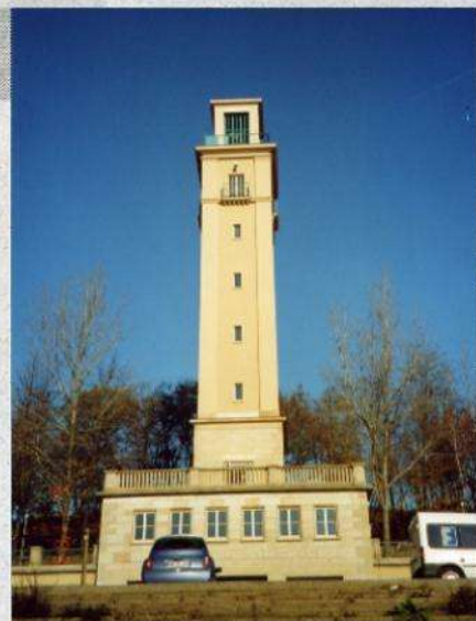
Saniertes Glockenturm. Ausführungszeitraum: März bis Oktober 2003.
